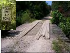
4.7 ton load limit
